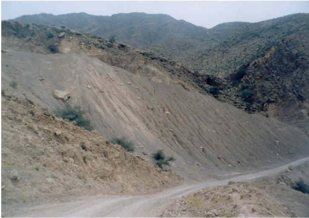
شکل ۳- فرسایش شیبی شدید در حاشیه جاده در دست ساخت در شهرستان برازجان (عکس از نویسنده)
