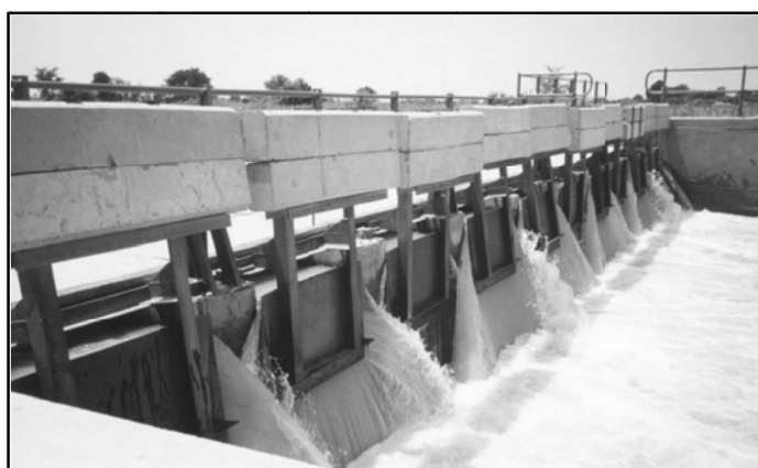
شکل ۲- نمایی از دریچه آویخته در شبکه‌های آبیاری
