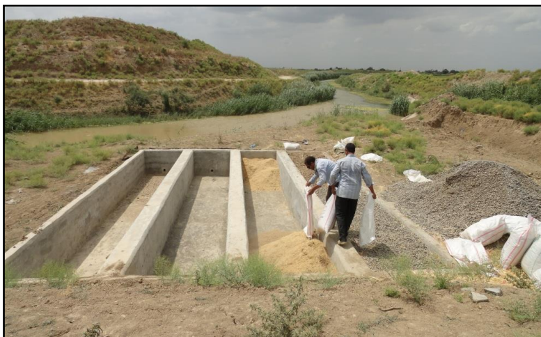
شکل ۱- پر کردن حوضچه‌ها با فیلتر (سبوس برنج)
