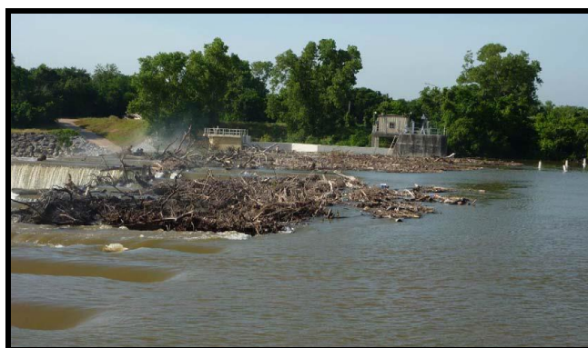
شکل ۱- تجمع اجسام شناور روی سرریز کنگره‌ای سد برازوس تکزاس
