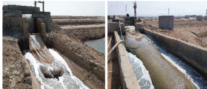
شکل ۶- تصویر استفاده از فیلتراسیون یک‌لایه در مزارع پرورش میگو که توصیه نمی‌گردد.
