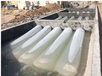
شکل ۹- ساختار فیلتراسیون چندلایه در مزارع پرورش میگو
