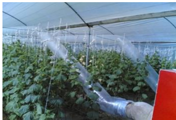
شکل ۳- بهبود یکنواختی توزیع حرارت در گلخانه با استفاده از لوله‌های توزیع هوای گرم
