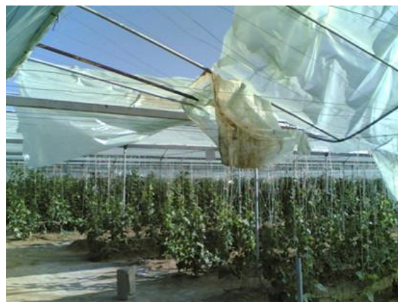
شکل ۶- نمایی از گلخانه تخریب شده در اثر طوفان در جیرفت
