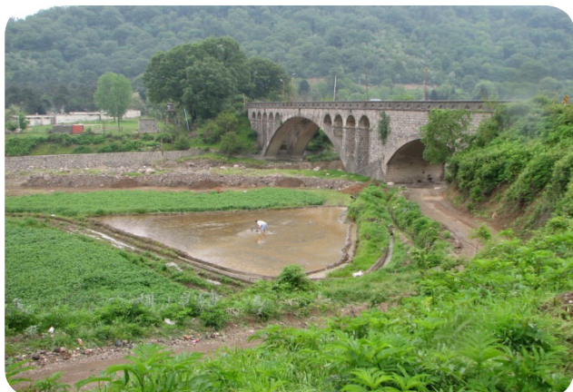
شکل ۴- تخریب کامل رویشگاه سفیدپلت در حاشیه رودخانه (مسیر آزادشهر به خوش‌بیلاق) با شالی‌کاری در حریم رودخانه
