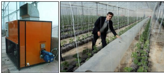
شکل ۲- استفاده از سیستم گرمایشی گازی و تونل باد گرم در گلخانه
