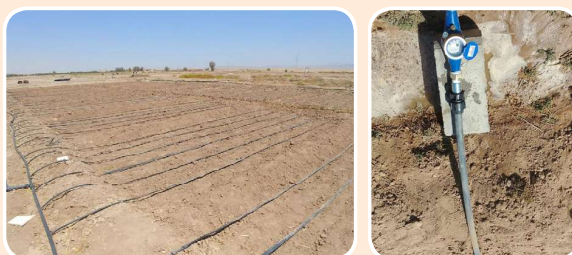
شکل ۱- آماده‌سازی زمین و سیستم آبیاری قطره‌ای (تیپ) و نصب کنترلر حجمی
