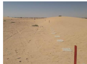
الف- آماده‌سازی عرصه قبل از مالچ‌پاشی a-Preparing the field before mulching
