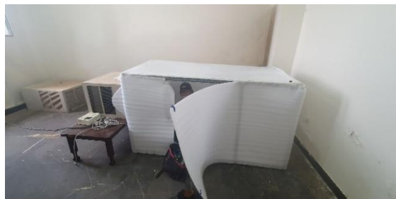
شکل ۴- نصب کولر گازی در یک انتها و تعبیه یک دریچه کنار محفظه
