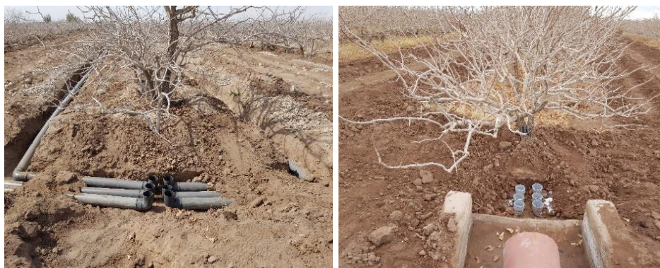
شکل ۲- نحوه اجرا و کارگذاری لوله‌ها در مزرعه
