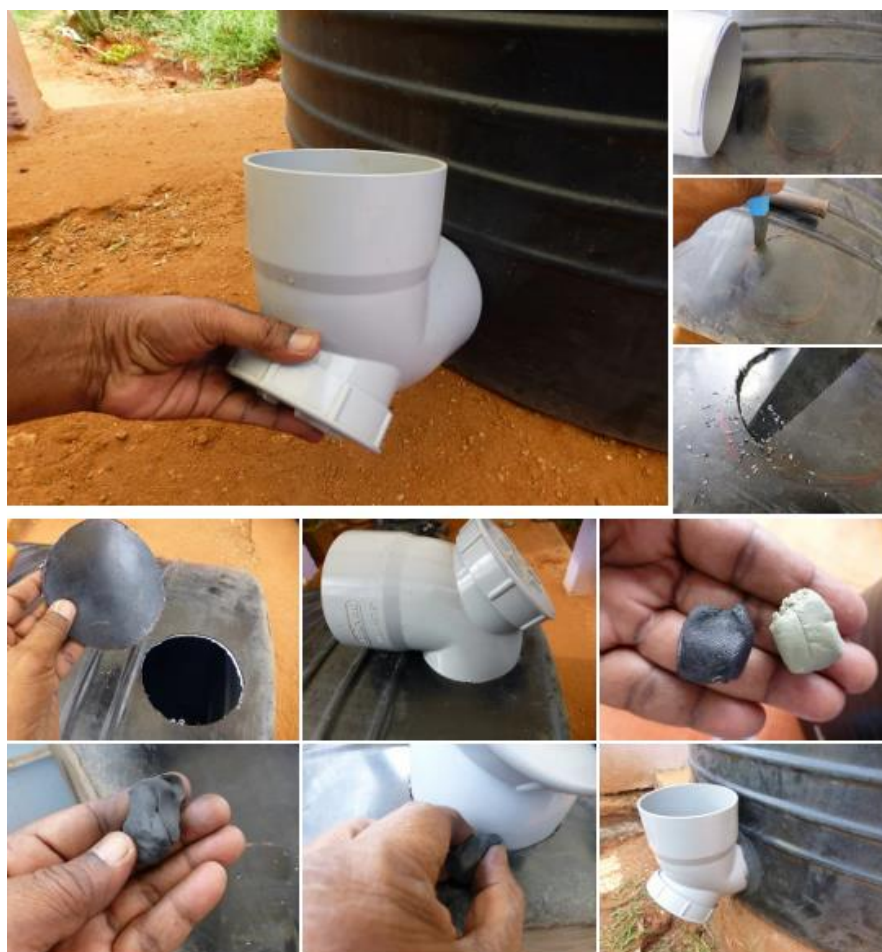
شکل ۴- نحوه اتصال لوله به مخزن هاضم
